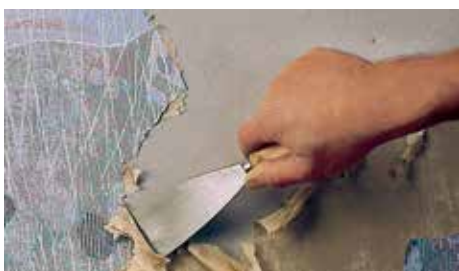
Befintliga ytskikt skall avlägsnas.
