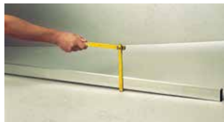
Kontrollera att inga svackor eller bulor förekommer innan tätskiktetsduken appliceras.
