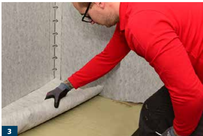
3 Applicera Sopro FDK 415 över hela ytan inkl. hela brunnsduken och täck sedan med Sopro AEB 815. Låt härda 8 timmar innan brunns överdel monteras.
