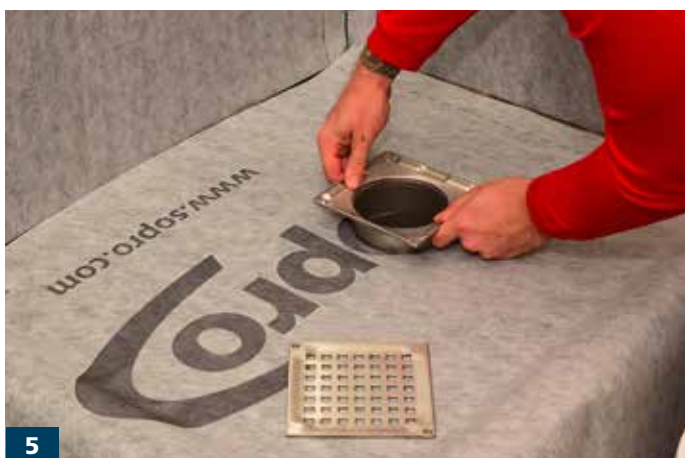
5 Montera brunns överdel enligt tillverkarens monteringsanvisning.
