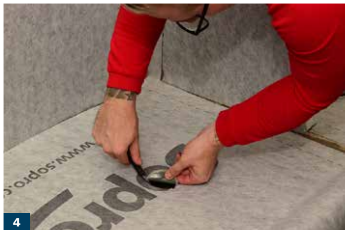
4 Skär ut ett hål enligt tillverkarens anvisningar (montageanvisning levereras med varje brunn).
