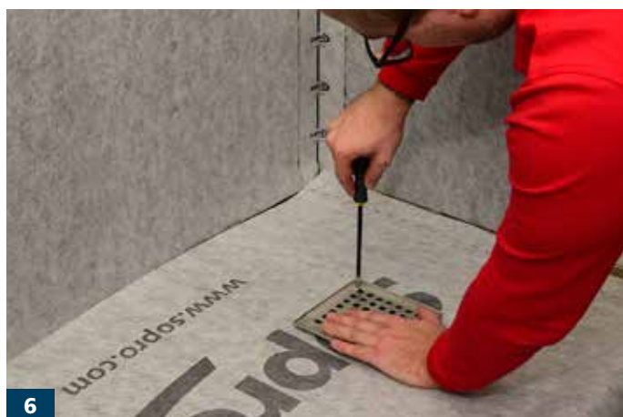
6 Gallerdelen skruvas fast med handkraft, använd inte maskinskruvdragare.
