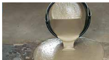
Avjämnning utförs med Sopro VS 582.
