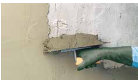
Ojämnheter spacklas ut med Sopro RS 462 eller Sopro USW 941.
