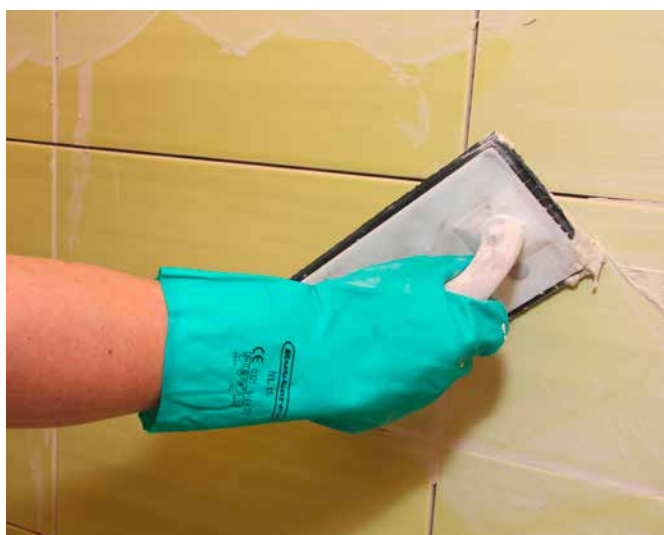
9 Fogning av lergodsplattor med Sopro DF 10®.
