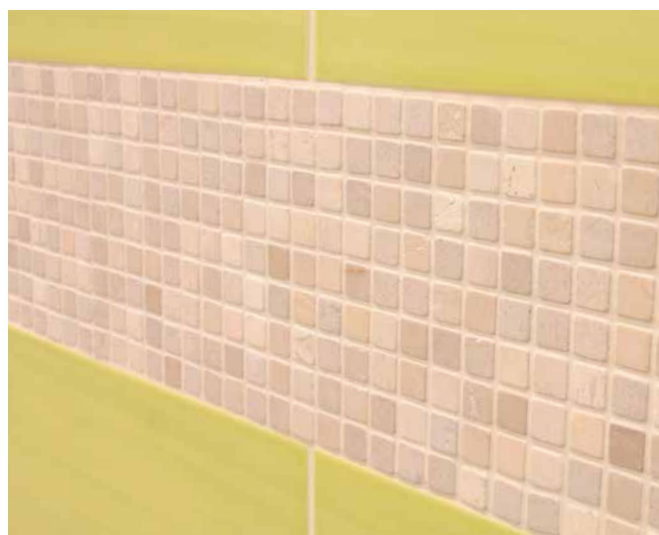
10 Lergodsytta och naturstensmosaik efter fogning med Sopro DF 10®.
